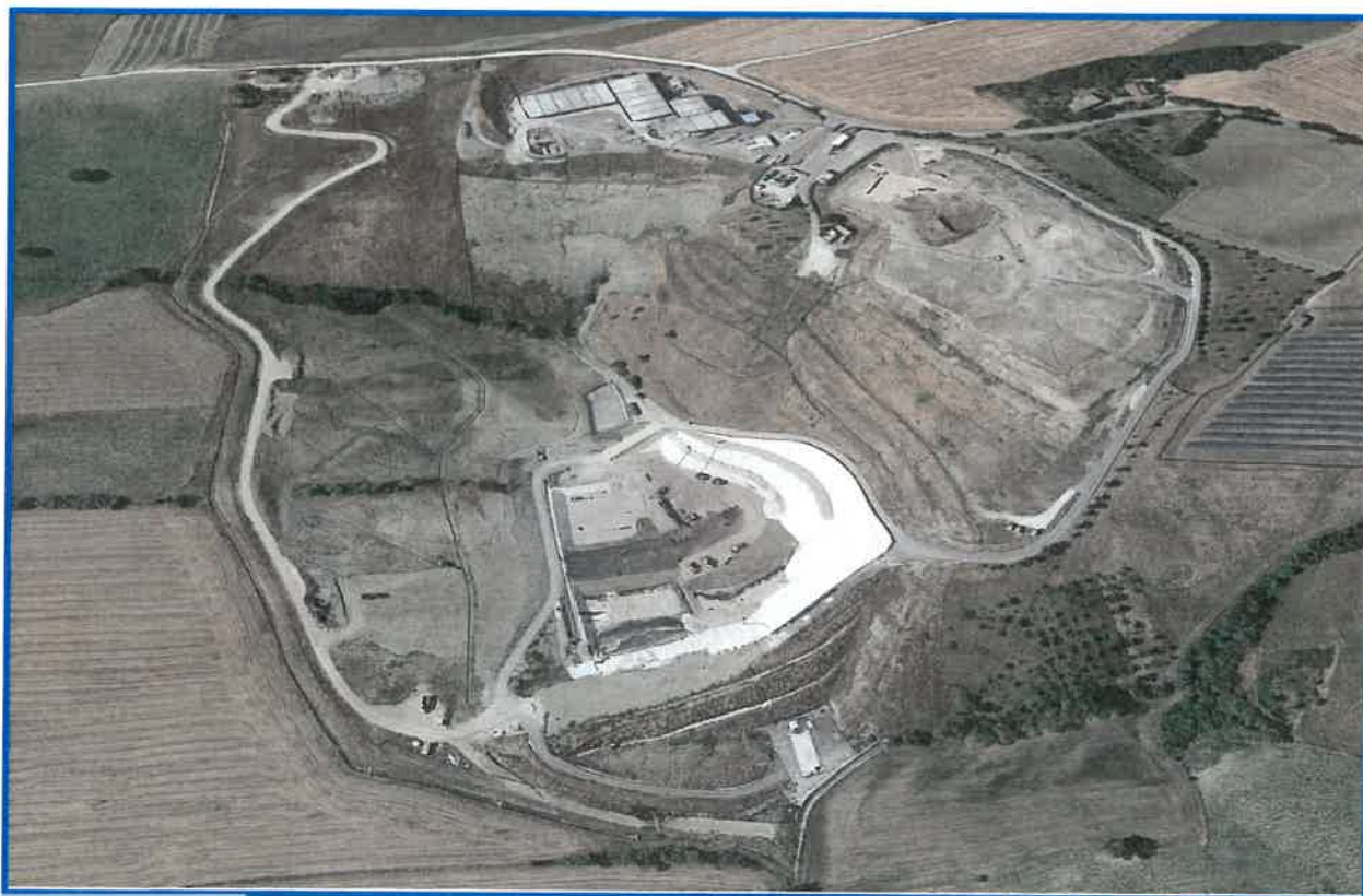
Foto panoramica impianto
