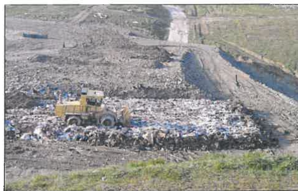
Abbancamento rifiuti nelle apposite celle
