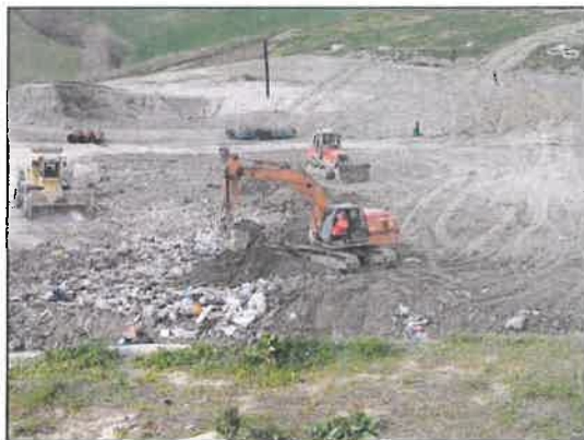
Copertura rifiuti con terra
