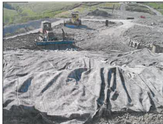
Copertura rifiuti con apposito telo
