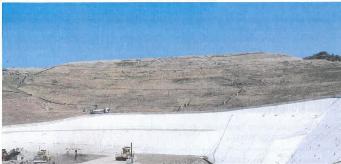
Foto relativa alla scarpata della discarica esistente (periodo luglio 2017)
