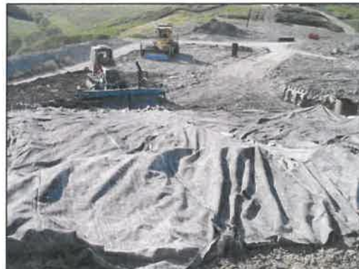
Copertura rifiuti con apposito telo
