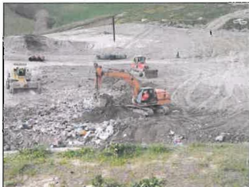
Copertura rifiuti con terra
