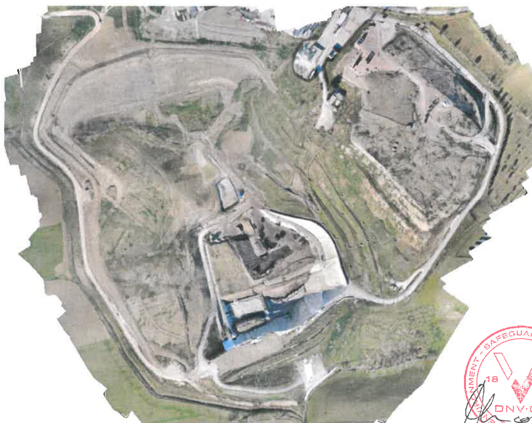
Foto panoramica impianto
