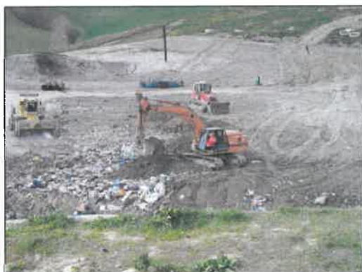
Copertura rifiuti con terra
