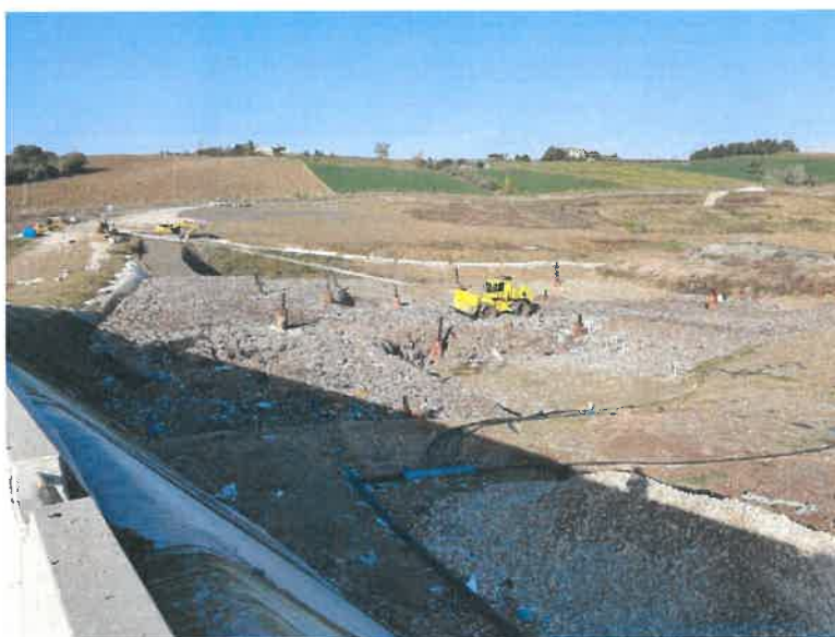
Visuale cella di abbancamento
