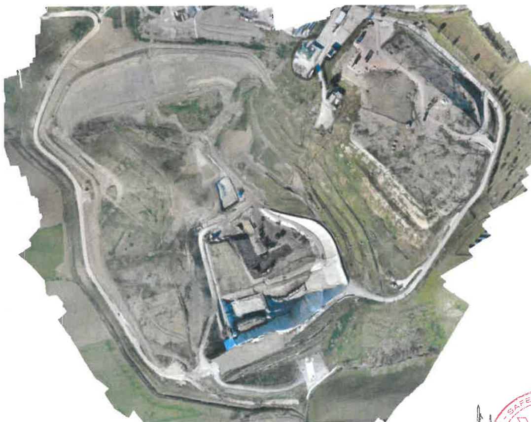
Foto panoramica impianto
