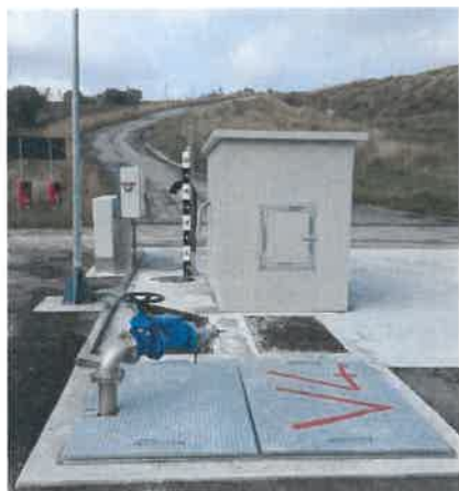
Visuale dell'asta graduata esterna per la misura del percolato dall'esterno
