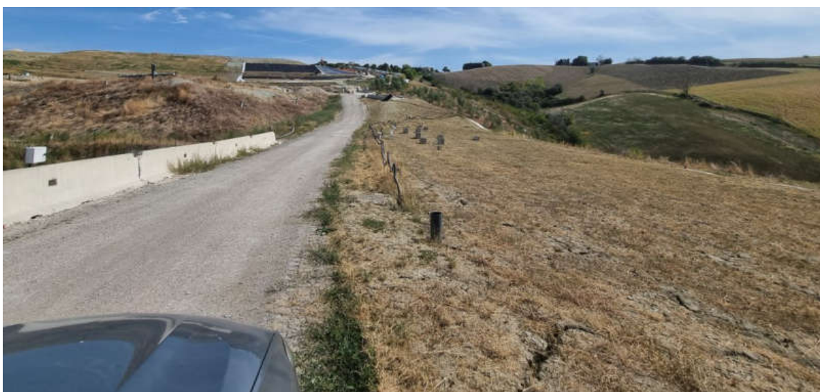
Figura 2 – Fotografia della sommità dell'argine presa nel sopralluogo del 13-9-2023
