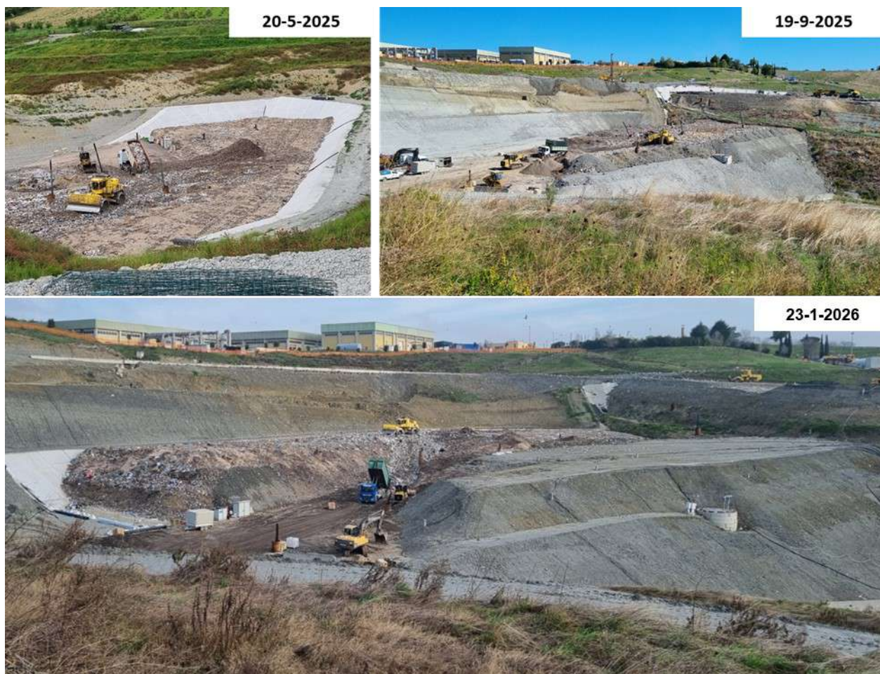
Figura 55 – Progressione dell'abbancamento nella porzione nord della discarica
