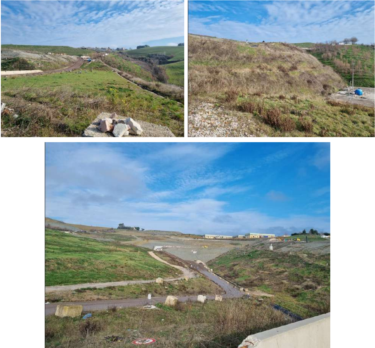
Figura 2 – Fotografie della sommità dell'argine, del fronte di valle dell'argine e della zona di attuale abbancamento prese il 23-1-2026
