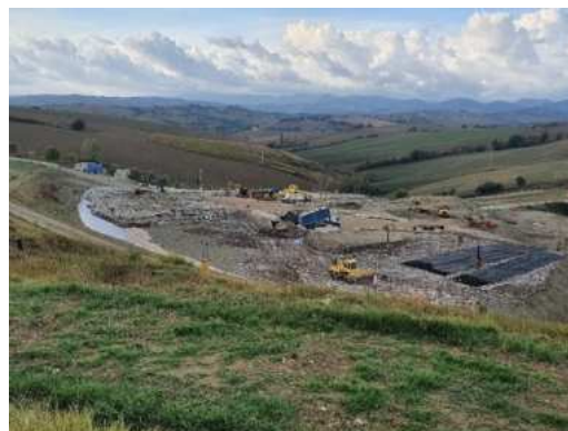
Abbancamento rifiuti nelle apposite celle
