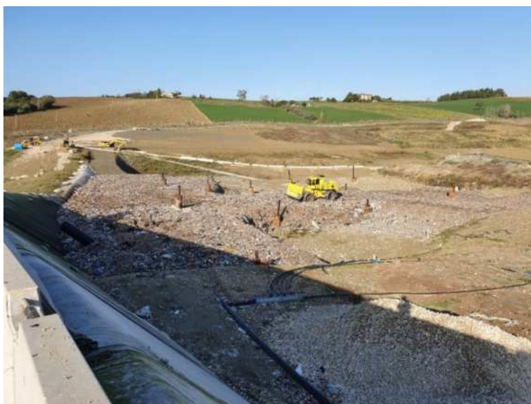
Visuale cella di abbancamento
