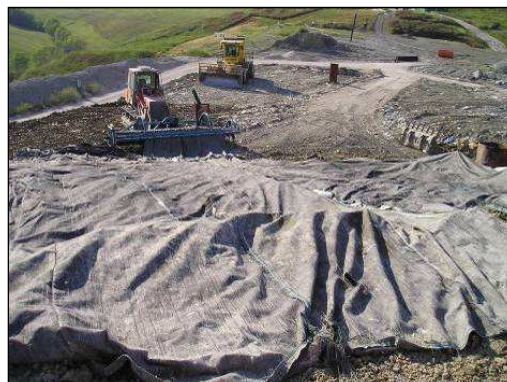
Copertura rifiuti con apposito telo
