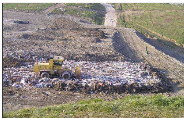
Abbancamento rifiuti nelle apposite celle
