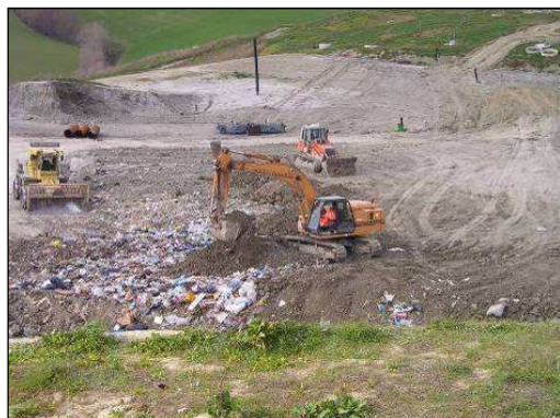
Copertura rifiuti con terra
