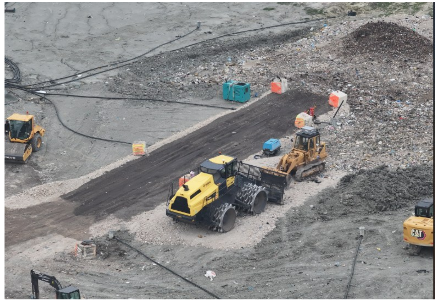
Particolare zona scarico "COSMARI"
