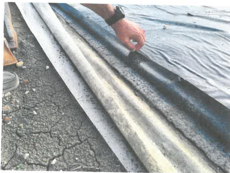
Figura 3 – Pacchetto impermeabilizzante in corso di installazione per il capping definitivo presso la vecchia discarica (foto del 12-10-2022)
