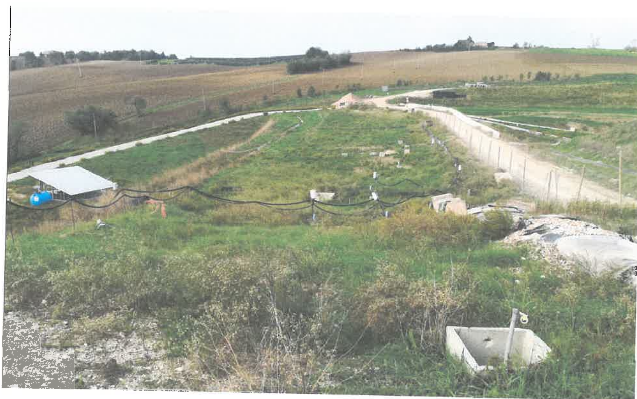
Figura 2 – Fotografia della sommità dell'argine presa nel sopralluogo del 12-10-2022
