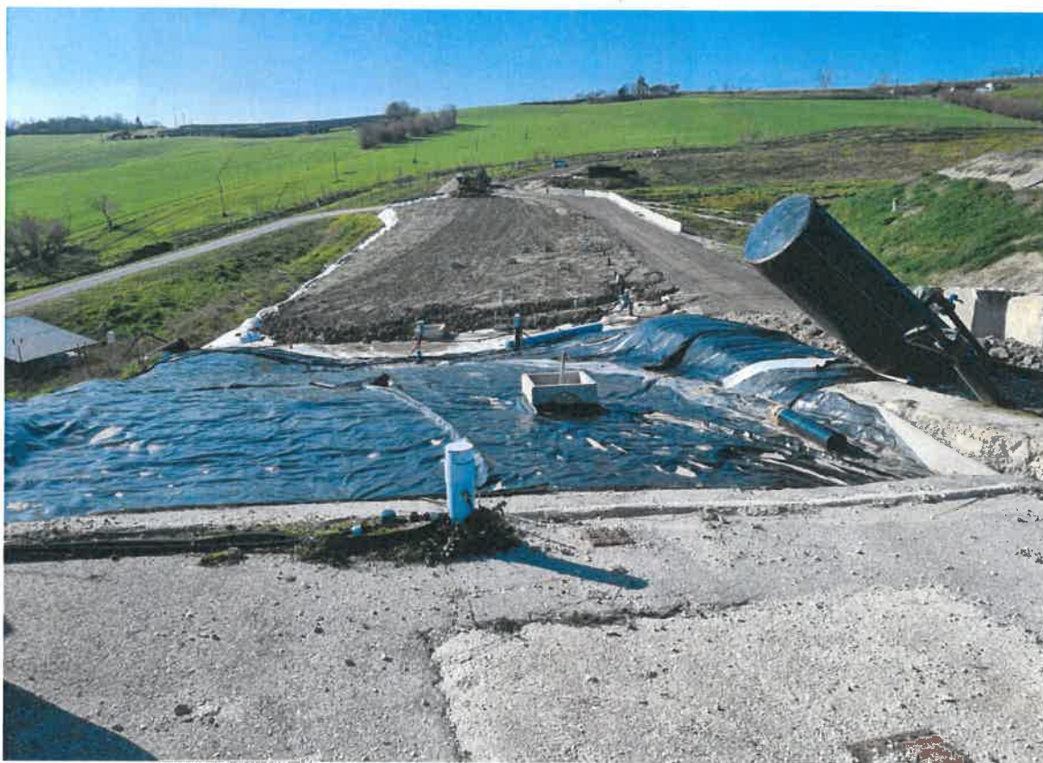
Figura 2 – Fotografia della sommità dell'argine presa nel sopralluogo del 31-1-2023
