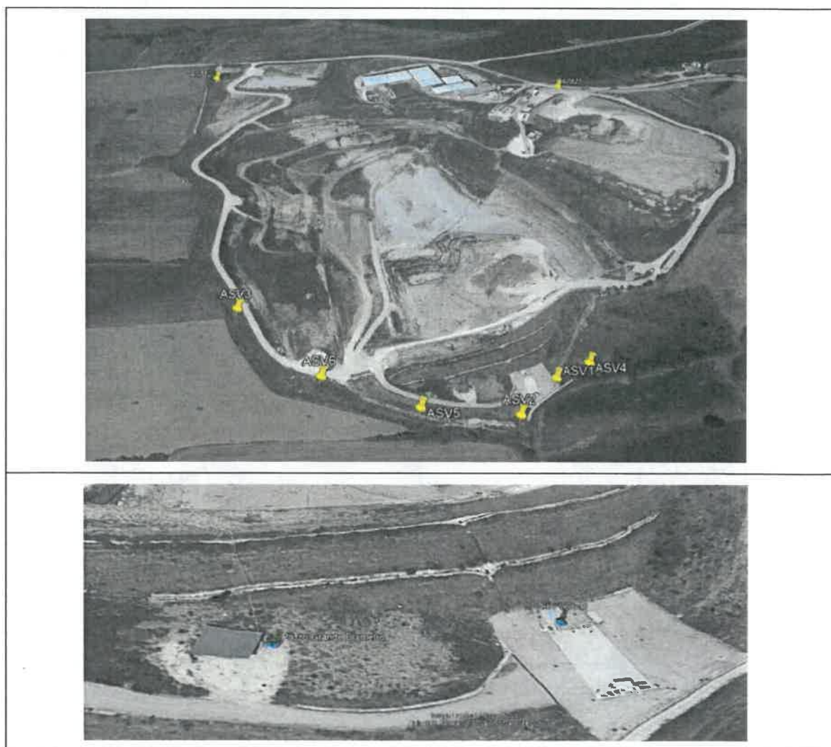
Figura 4 - Localizzazione dei punti di prelievo acque sotterranee
