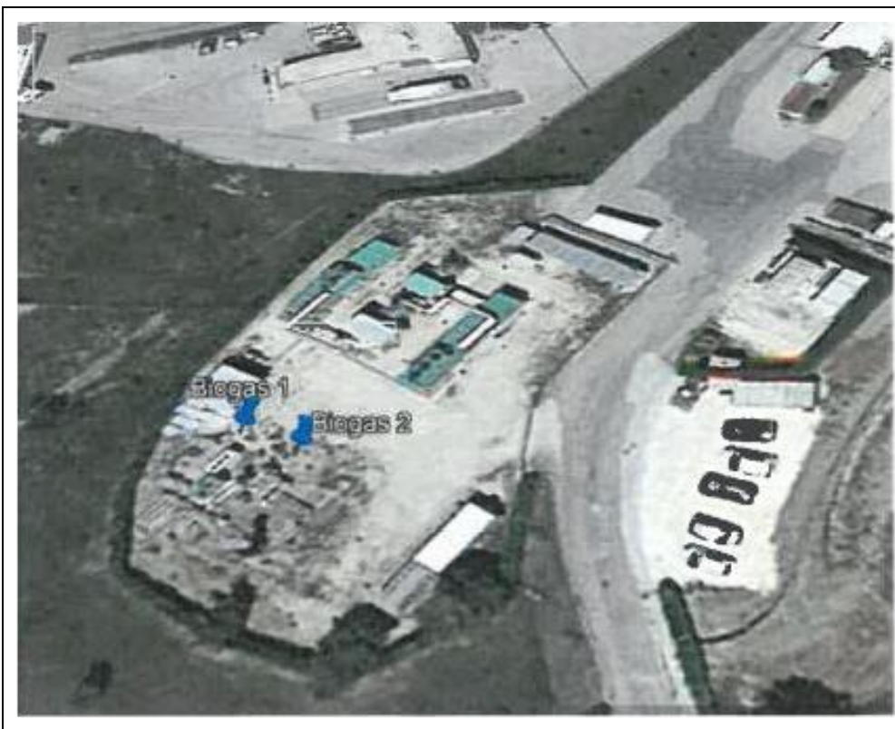
Figura 2 - Localizzazione dei punti di misura biogas
