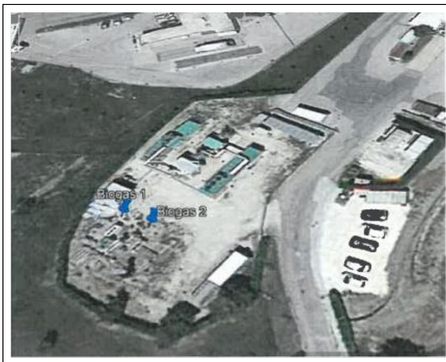
Figura 2 - Localizzazione dei punti di misura biogas
