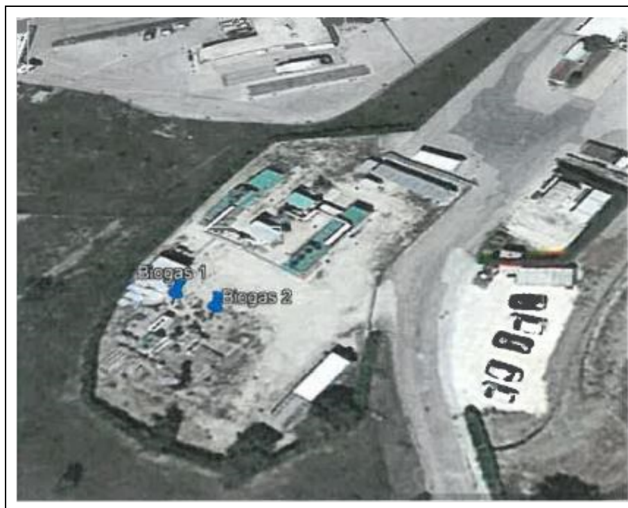
Figura 2 - Localizzazione dei punti di misura biogas
