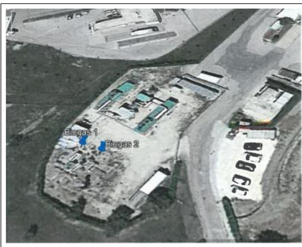
Figura 2 - Localizzazione dei punti di misura biogas
