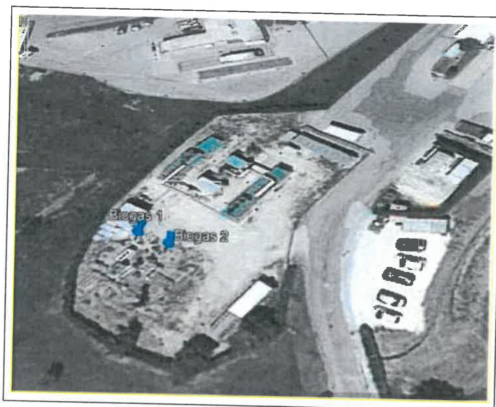
Figura 2 - Localizzazione dei punti di misura biogas
