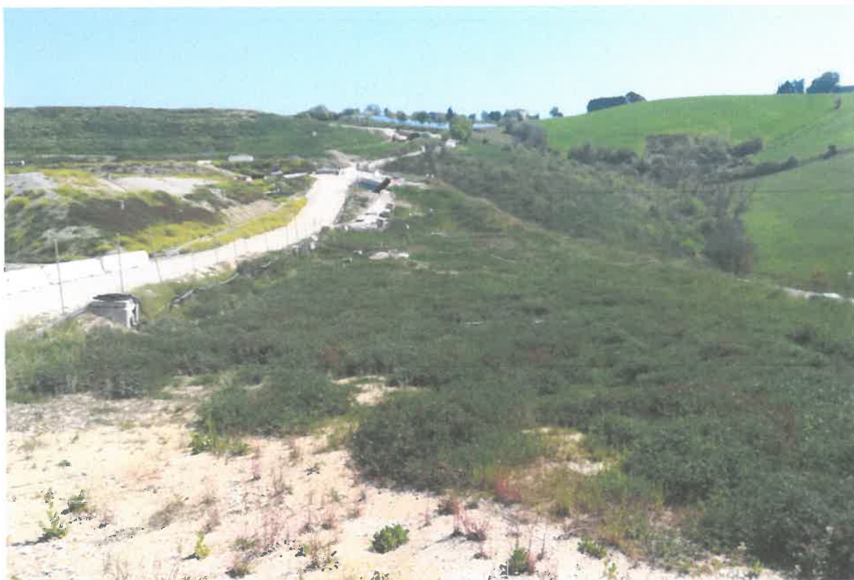
Figura 2 – Fotografia della sommità dell'argine presa nel sopralluogo del 29-04-2022
