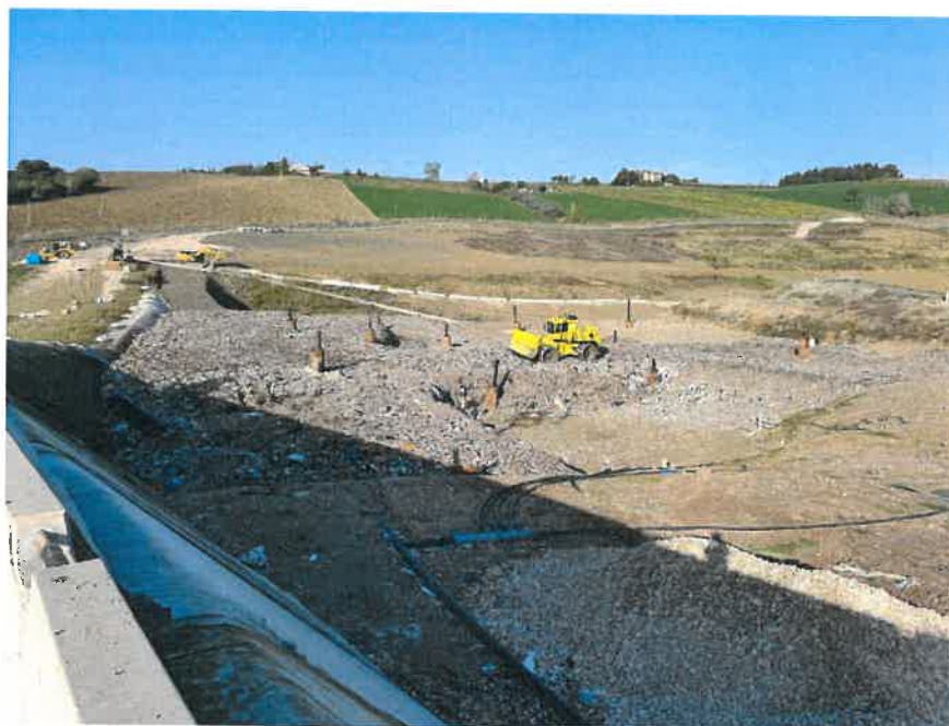
Visuale cella di abbancamento
