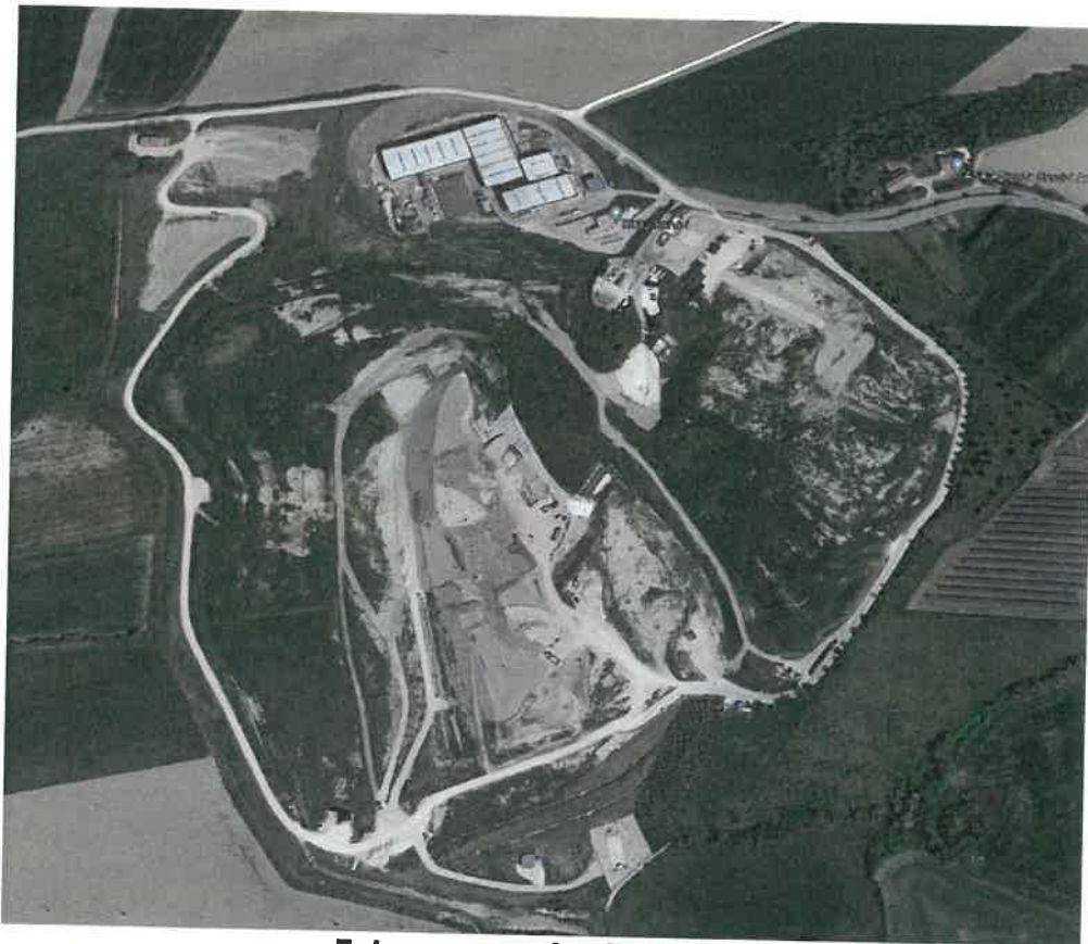
Foto panoramica impianto
