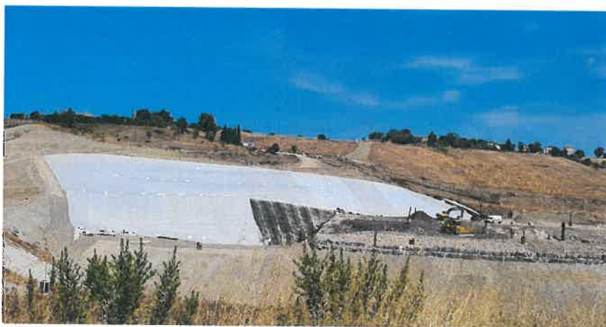
Copertura rifiuti con terreno e con materiale inerte riciclato
